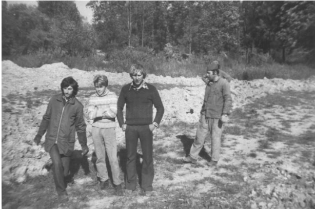
akce „ZET“ (stavba fotbalového hřiště)
